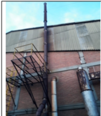
FOTOGRAFIA 7. DUCTO DE DESCARGA DE LA TOSTADORA
